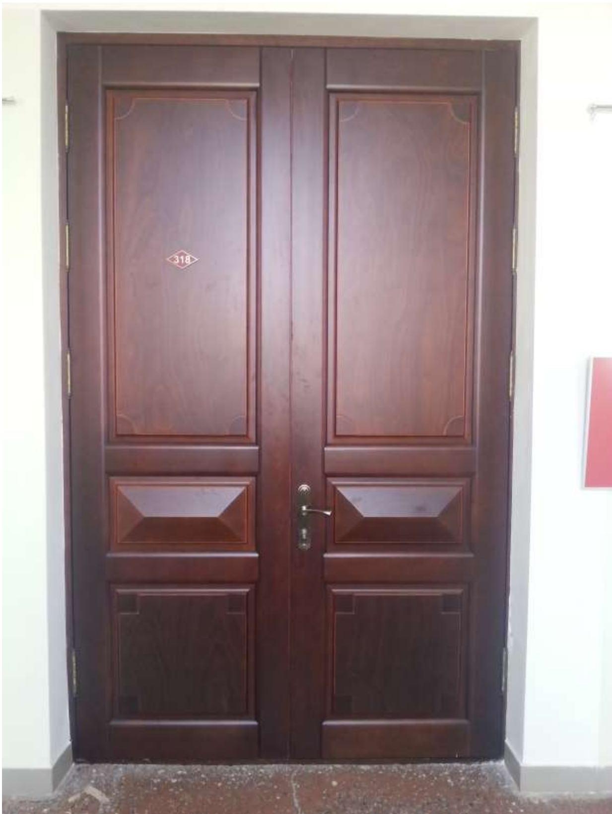
Рис. 1 - Наружная сторона дверного блока из массива ольхи (каб. 318)
