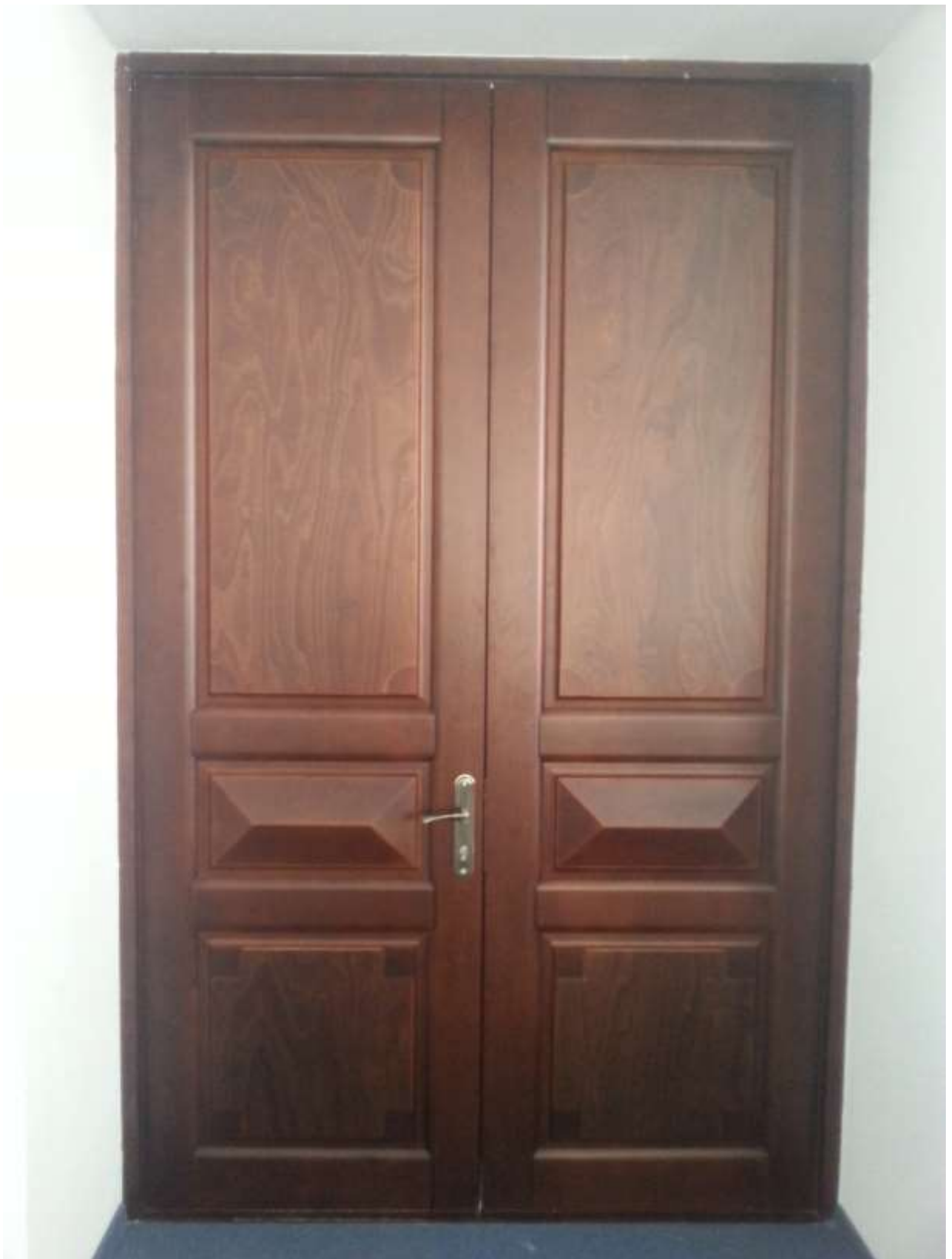
Рис. 2 – Внутренняя сторона дверного блока из массива ольхи (каб. 318)
